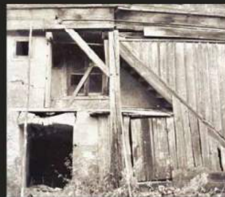
20. gs. 70.-80. gadi. Skats no pagalma puses. Piebūve ar ārējo kāpņu telpu uz otro stāvu un izbūvēto ārējo sauso tualeti.
