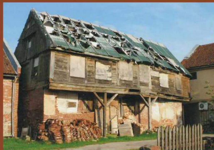
2012. gads. Pirms uzsāktajiem lielajiem restaurācijas un pamatu nostiprināšanas darbiem. Uzsākot restaurācijas darbus, pagaidu jumta zaļā vēja plēve bija stipri paplosīta un nokalpojusi.
