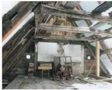
Skats uz jumta konstrukciju.
