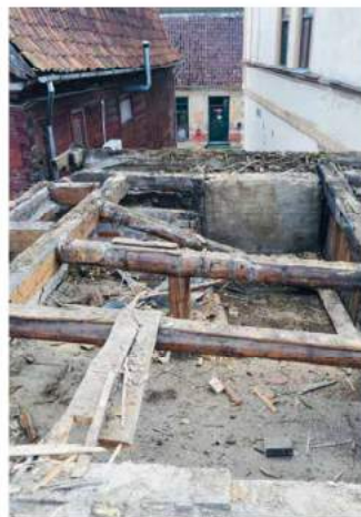
Atsegtā konstrukcija pirmā stāva griestos, kurā bija ieejas durvis otrā stāva grīdā. Iespējams, telpa kalpoja kā slēpnis Otrā pasaules kara laikā.
