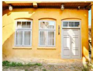
Fasāde pret Liepājas ielu.
