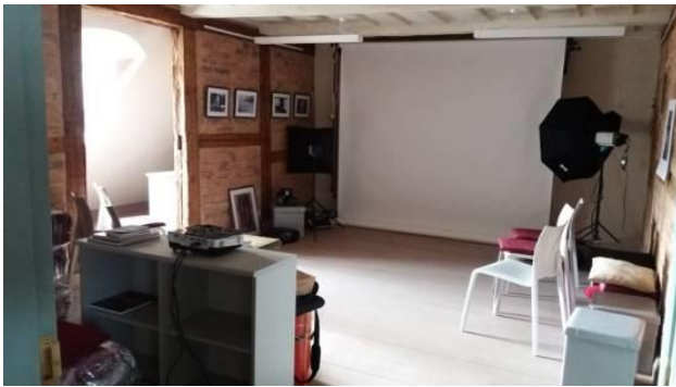
23. un 24. att. Pēc pārbūves. Daļēji pievienotas aukstās pažobeles apkurināmai telpai - ar atvērumiem pildrežģu sienās, lai nodrošinātu izgaismošanu no izveidotajām jumta izbūvēm.
