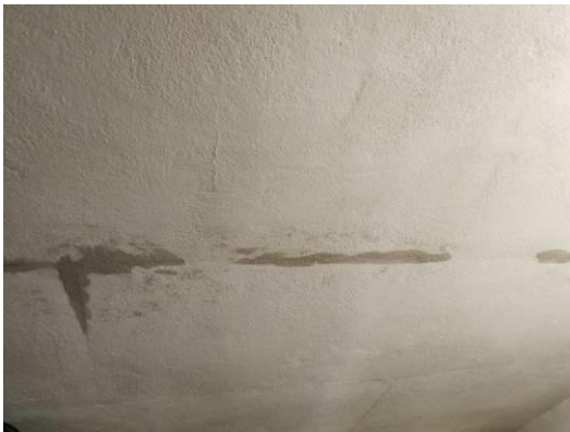
25.att. Pēc pārbūves. Uz fibrolīta plāksnēm iestrādāts apmetums ir pārvērtējams risinājums, īpaši vēsturiskā koka ēkā, kur tā pēc atjaunošanas vēl sasēžas un parādījušās plaisas starp 20 plāksnēm un līdz ar to apmetumā. Iesakāms šāda veida plākšņu apdare ar koka dēļiem, kuros nebūtu nolasāmas plaisas.
