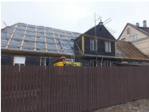
26. att. Uz jumta difūzijas plēve - zem seguma - māla kārņiņiem. 27. att. Jumta plaknes siltinājums ar kokšķiedras plāksnēm.
