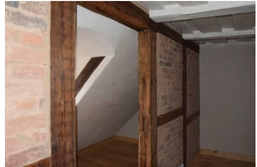
23. un 24. att. Pēc pārbūves. Daļēji pievienotas aukstās pažobeles apkurināmai telpai - ar atvērumiem pildrežģu sienās, lai nodrošinātu izgaismošanu no izveidotajām jumta izbūvēm.
