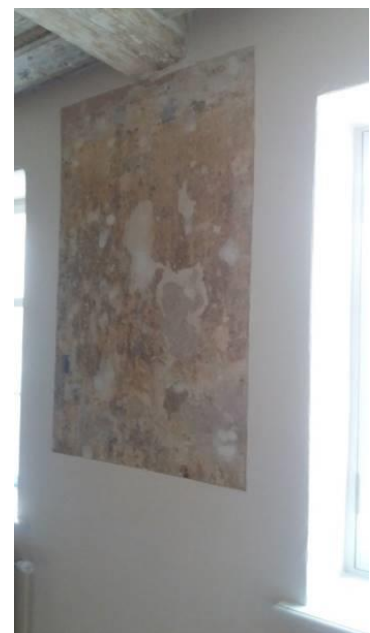
6. un 7. att. Saglabāti esošie un izveidoti jaunie kaļķu javas apmetumi.
