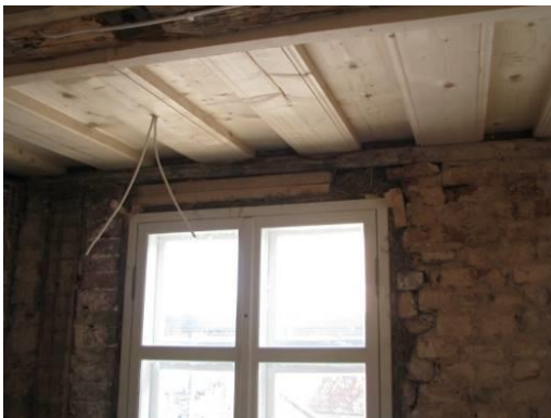
8 un 9. att. Atjaunojamais logs ar tajā iestrādātajiem blīvēšanas risinājumiem – blīvgumijām un ķītētu stiklu ārējās vērtēs. 13
