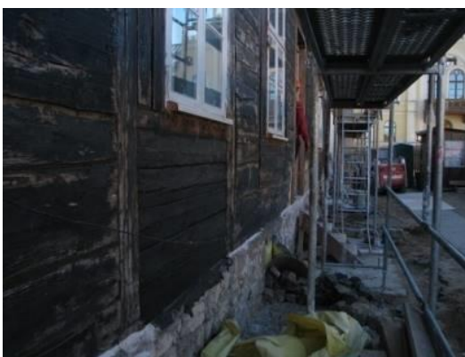
10., 11., 12. att. Loga bloka iestrāde dažādu materiālu sienās ar blīvinājumu - lina pakulām. 14
