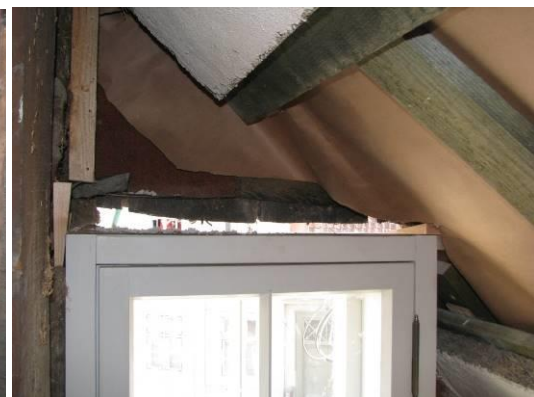
28. un 29. att. Virs kokšķiedras plāksnēm ierīkota tvaika barjera, latas un fibrolīta slānis, pēc tam izveidots kaļķu javas apmetuma slānis.
