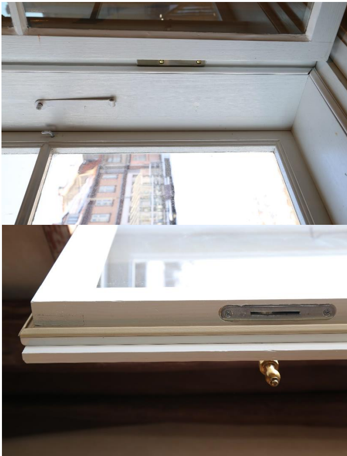
8 un 9. att. Atjaunojamais logs ar tajā iestrādātajiem blīvēšanas risinājumiem – blīvgumijām un ķītētu stiklu ārējās vērtēs. 13
