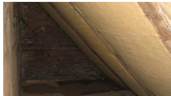
26. att. Uz jumta difūzijas plēve - zem seguma - māla kārņiņiem. 27. att. Jumta plaknes siltinājums ar kokšķiedras plāksnēm.
