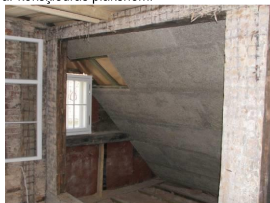
28. un 29. att. Virs kokšķiedras plāksnēm ierīkota tvaika barjera, latas un fibrolīta slānis, pēc tam izveidots kaļķu javas apmetuma slānis.
