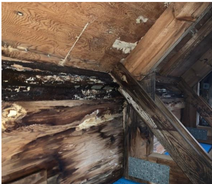
5.att. Būvkonstrukciju koksnes trupe
