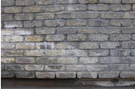
9.att. Sāļu nogulsnes uz ēkas ārsienas ārējās virsmas
